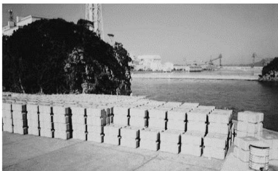
図6 作業船に積み込むため岸壁に2段積みしたブロック
