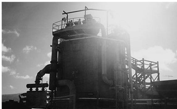
図1 210 kW オープンサイクルOTEC施設
