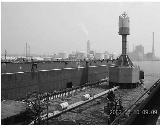
図8 浮体と取水管の最終組立て
